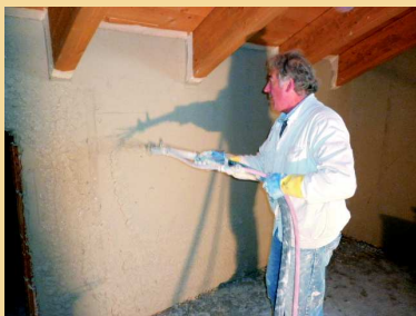
Parete interna , Fase di stesura meccanica del primo strato di intonaco.
