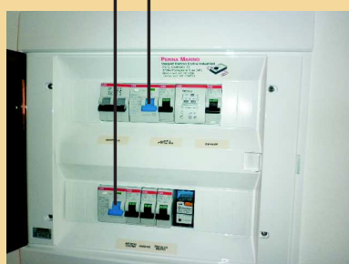
Diff. magnetotermico generale alloggio 2x25 0,03
