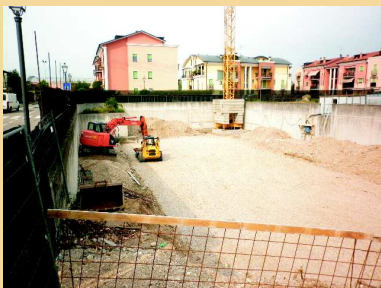
Area di scavo , fase preliminare per i successivi getti di fondazione
