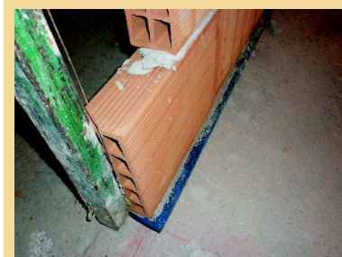
Parete divisoria interna , dettaglio della posa all'attacco del solaio di una striscia elastomerica fonosmorzante "FONOSTRIP" di Index rivestita su entrambi i lati con un velo di fibre polipropilenuche di 4 mm che, posta sotto le pareti divisorie, impedisce la trasmissione di urti e vibrazioni al solaio.
