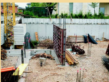
Murature di elevazione , fase di armatura per il successivo getto in opera.
