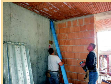
Colonne di scarico , fase di posa intrasoalio di una tubazione silenziata.
