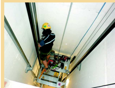
Ascensore , dettaglio della fase di posa.
