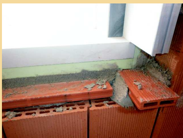
Bancale finestra in Pietra "Trani" , dettaglio del nodo bancale controcaassa del serramento con profilo metallico e termocobentato per eliminare i ponti termici. il contro-bancale è coibentato ai lati e sulla pancia con pannello di Polistirene.
