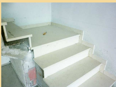
Pavimentazione scala interna , dettaglio della posa delle alzate e pedate in "Biancone" e dei rispettivi zoccolini.
